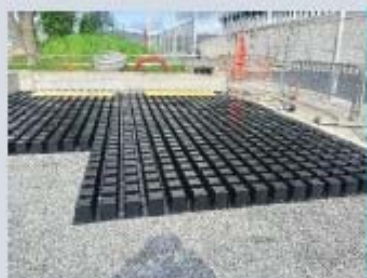
COLOCACION DE MOLDE PARA EL HORMIGON Y LA HIERBA
