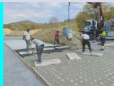
FASE DE HORMIGONADO A RAS DE LA PARTE SUPERIOR DEL MOLDE
