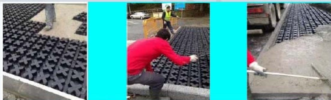
COLOCACION DE MOLDE PARA EL HORMIGON Y LA HIERBA
