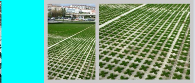
PAVIMENTO HIERBA HORMIGON REALIZADO CON MOLDE PALEX CE15
