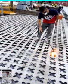
ROTURA Y QUEMADO DE LA PARTE SUPERIOR Y PAREDES DEL MOLDE
