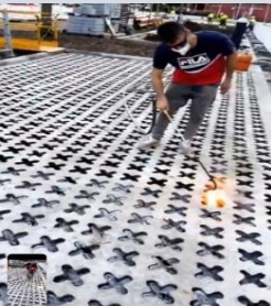
ROTURA Y QUEMADO DE LA PARTE SUPERIOR Y PAREDES DEL MOLDE
