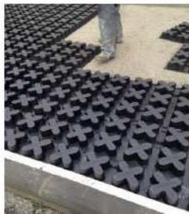
COLOCACION DE MOLDE PARA EL HORMIGON Y LA HIERBA
