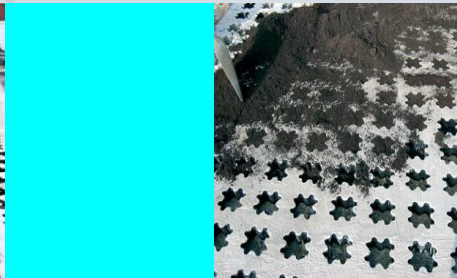
RELLENO CON TIERRA VEGETAL Y SEMILLADO
